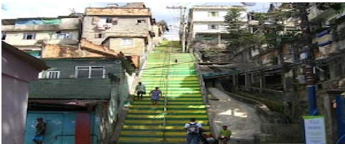
Figura 4 – Escadaria da Ladeira do Barroso. Fonte: http://www.rioonwatch.org.br , 2015.
